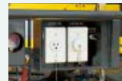
コンセント部
