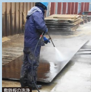
敷鉄板の洗浄
