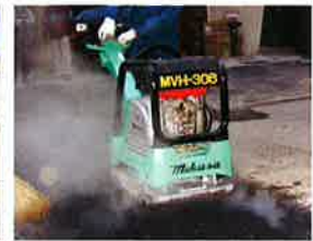
MVH-306DSC アスファルト転圧
