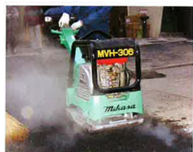
MVH-306DS アスファルト輾圧
