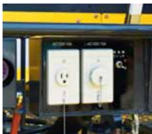
コンセント部
